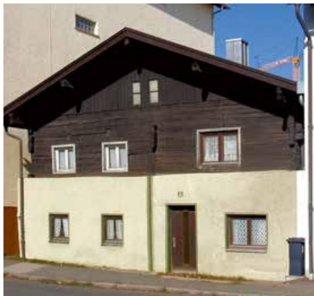
Denkmalgeschützt: das Museum der Sektion Viechtach
